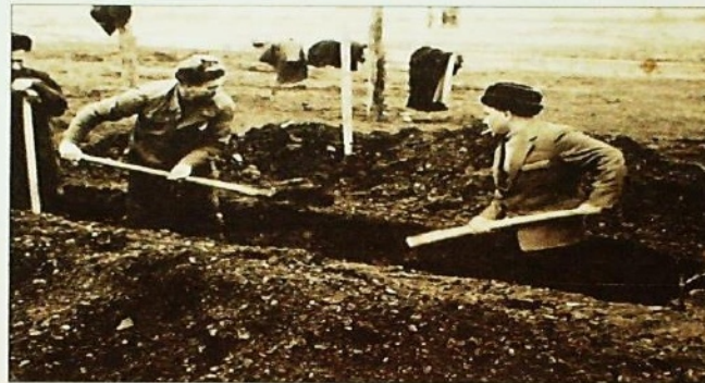
Закладка фундамента быстрогорской школы, где Филипп Высовень (справа) помогает рыть траншею (4 декабря 1961 г.)
