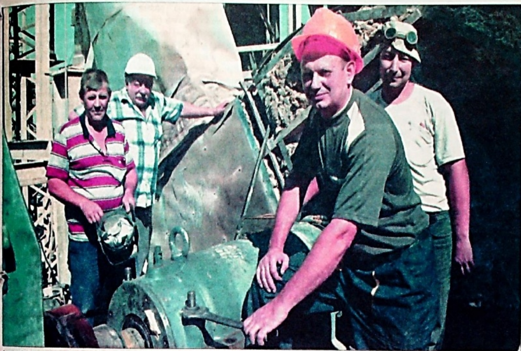
Андрей Гладченко, Владимир Мостовой, Алексей Петрухин и Сергей Репин (слева направо) производят ремонт дымососа печи.
