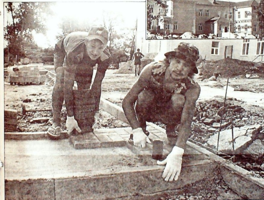
Мастер по укладке тротуарной плитки Иван Митин (справа) и подсобный рабочий Алексей Погорельский понимают, что начало учебного года совсем скоро, и поэтому торопятся выполнить задание по благоустройству школьного двора. Фото С. Баянова
