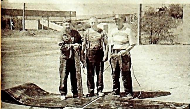
Члены ремонтной бригады Алексей Дубовик, Дмитрий Боевой и Виктор При- ко (слева направо) заготавливают впрок ленту для конвейера.
